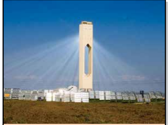
चित्र 8 : स्पेन के एक पावर प्लांट का चित्र जो विद्युत उत्पादन करने वाले जेनरेटरों को चलाने वाली भाप बनाने के लिए कोयले के बजाय सूर्य की ऊर्जा का उपयोग करता है। हवा में मौजूद धूल के कारण, हम वास्तव में सूर्य की किरणों के पथ को देख सकते हैं।
